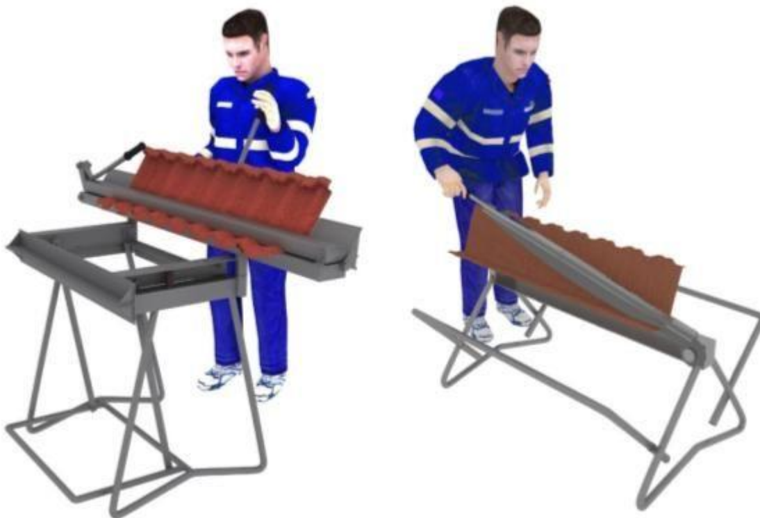
Stříhání a ohýbání šablony na hřebeni pomocí nůžek a ohýbačky
