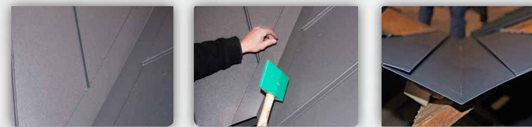
Montáž úžlabního plechu a ukotvení šablon, obrázky č. 15
