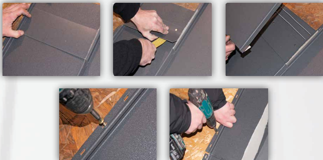
Správné napojení spodních a horních šablon, obrázky č. 12
