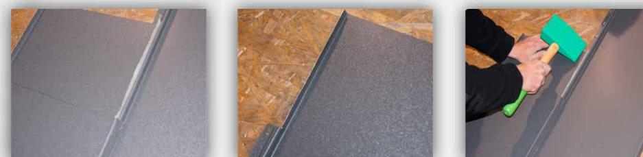
Spojení šablon Omak Click Panel, obrázek č. 11
