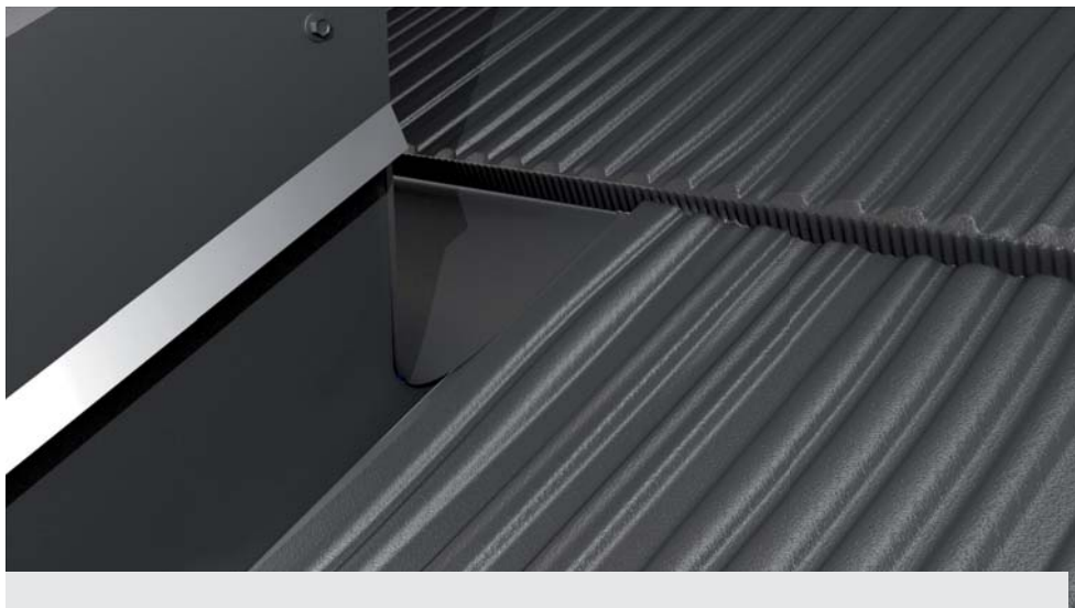
Zadní část lemování komínu po montáži krytiny.
